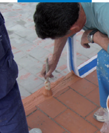
Impermeabilizzazione di un giunto di frazionamento con Mapeband fissato con Aquaflex Roof
