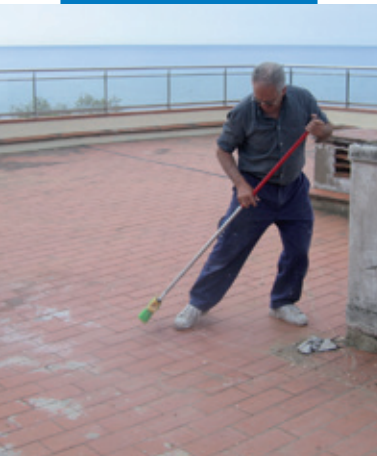
Pulizia del supporto prima dell'applicazione di Aquaflex Roof
