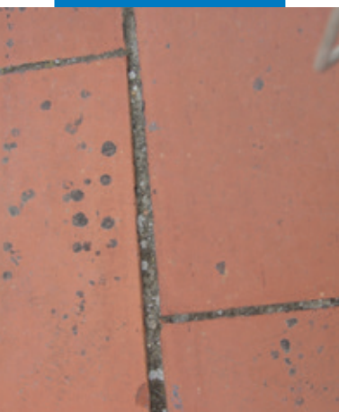
Pavimentazione esistente in cotto che necessita di preparazione prima della posa di Aquaflex Roof
